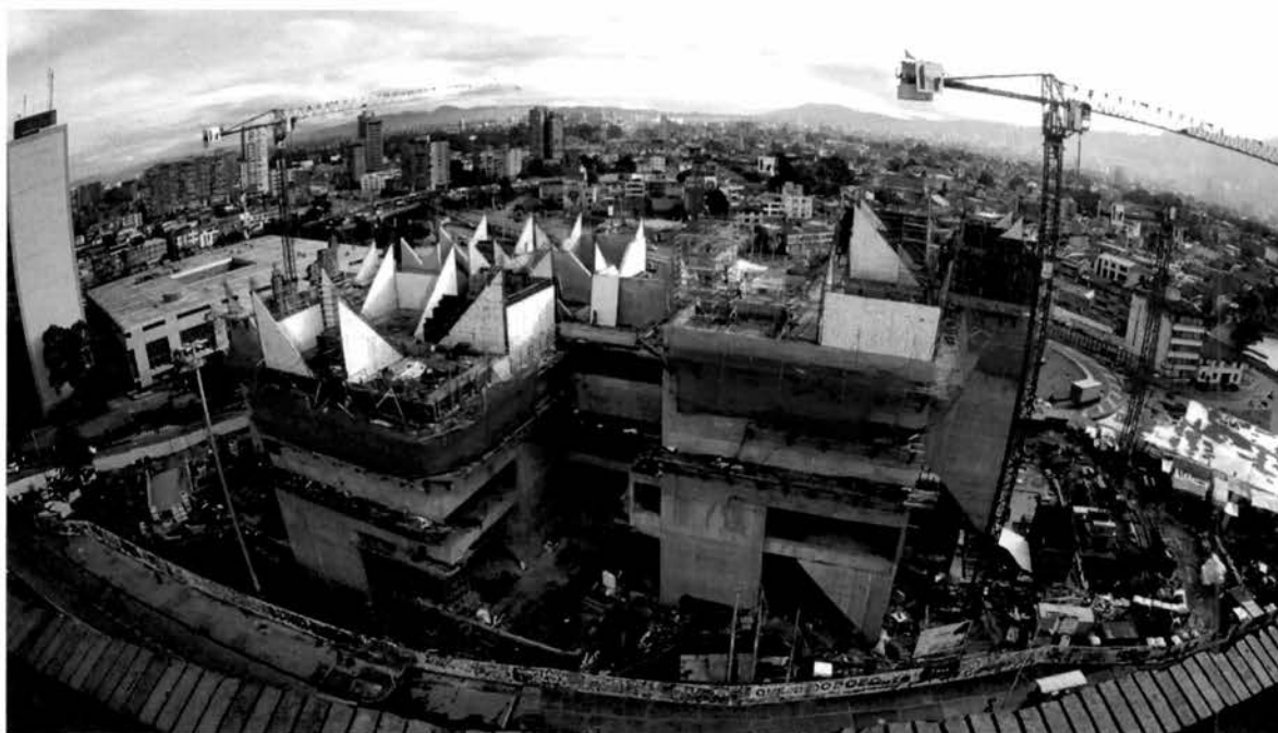
Figura 1. Panorámica construcción Museo de Memoria de Colombia.
