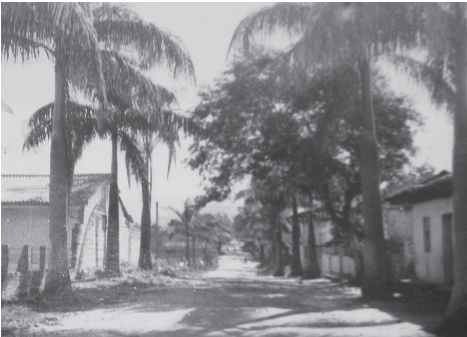
Figura 17a. Calles sin pavimentar. Fuente: archivo personal.
