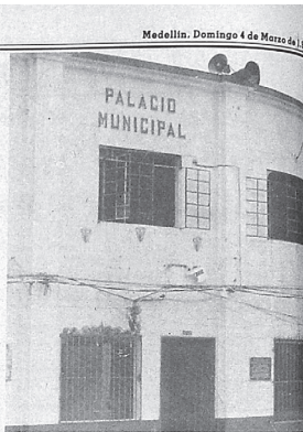
Este aspecto presentaba el Palacio Municipal de San Carlos, luego del paro cívico que afectó a esta población. Ventanales y vidrios los muros quedaron destruidos.
