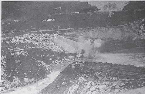
A las 8 y 22 minutos de la mañana sonó la explosión de una carga de dinamita que abrió el tapón natural sobre la margen derecha del río Guatapé. A un lado se observa el túnel por el que fueron desviadas las aguas del río con la que se facilitará la construcción de la presa de 65 metros de altura y 450 metros de longitud.
