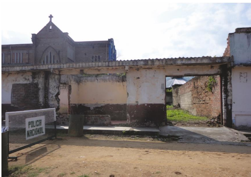
Debido a los constantes ataques a la estación de policía toda una manzana del municipio de Algeciras (Huila) permanece abandonada. Marzo de 2014. Fotografía: © William Mancera para el CNMH.
